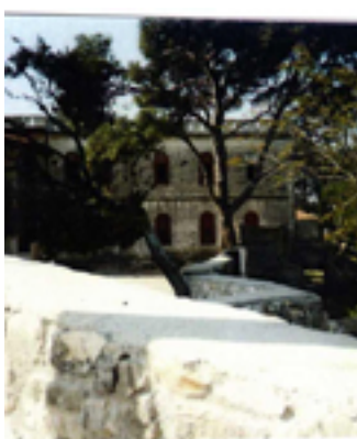
Εξωτερική άποψη της Μονής
